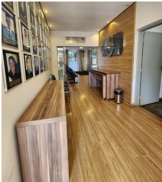
Figura 7 – Recepção, será demolido o piso vinílico existente para construção de um novo vinílico.
