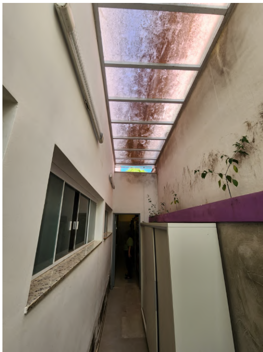
Figura 15 – Na área de serviço, deverá ser feita a retirada do jardim do muro de contenção e fechamento do canteiro com alvenaria ou argamassa. Manutenção e limpeza na cobertura
