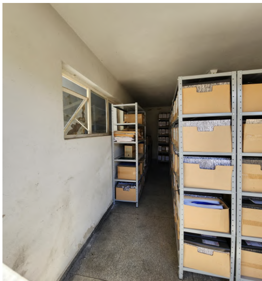
Figura 19 – Na garagem deverão ser feito a manutenção, lixamento, pintura e impermeabilização na janela J1.
