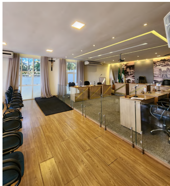
Figura 8 – Plenário, será demolido o piso vinílico existente para construção de um novo vinílico. A rampa será deslocada para dentro do piso elevado sendo construída como elemento fixo no piso.
