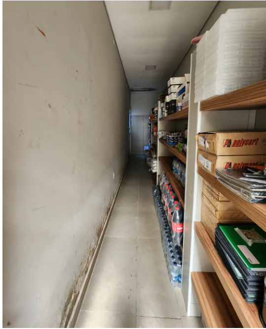
Figura 17 – No almoxarifado as divisórias de MDF serão removidas e construídas novas divisórias de ardósia, aumentando um nível acima das paredes de sustentação.
