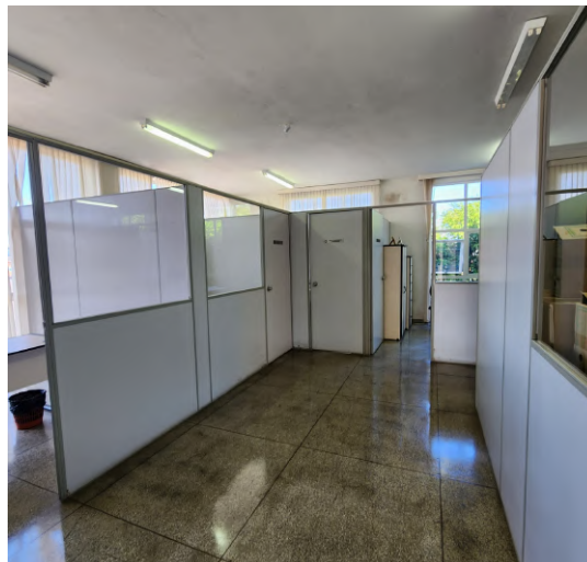
Figura 2 – Divisórias de madeira a serem demolidas, para construção de divisórias de Dry Wall de acordo com o novo layout presente no projeto arquitetônico.
