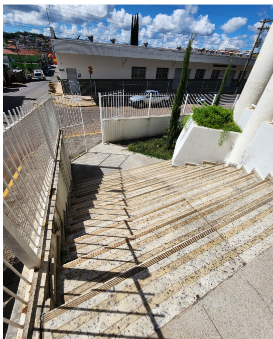
Figura 24 – Na escada de entrada, será realizado a limpeza das pedras, instalação de um adesivo ante derrapante, além da substituição da primeira pedra.
