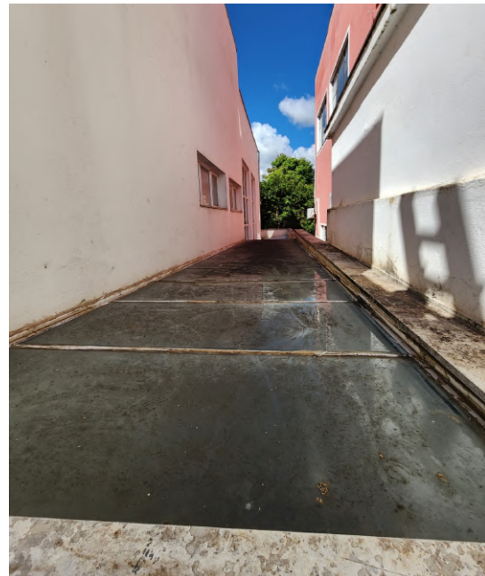
Figura 35 – O telhado de policarbonato será instalado um rufo metálico na lateral esquerda e realizado sua limpeza.
