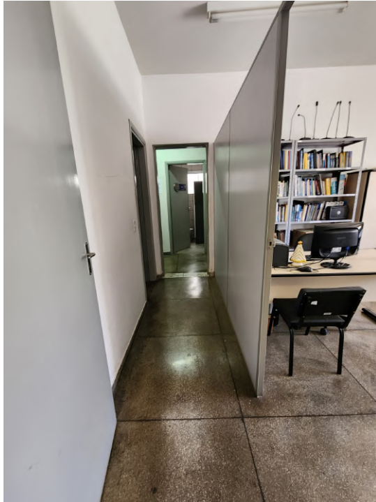
Figura 9 – Divisória de madeira a ser demolida e porta P5 removida, para construção de uma divisória em Dry Wall conectada até a laje do segundo pavimento junto a uma porta P6.
