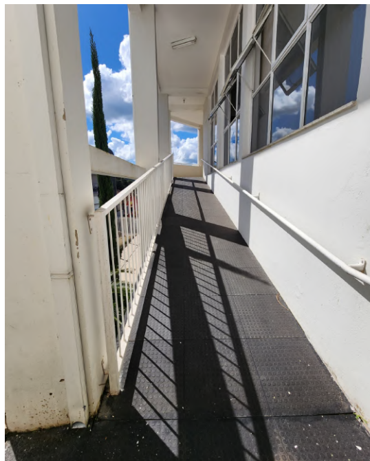
Figura 23 – Os corrimãos e guarda-corpo serão removidas e instalados novos elementos de proteção e guia de acordo com a NBR 9050.
