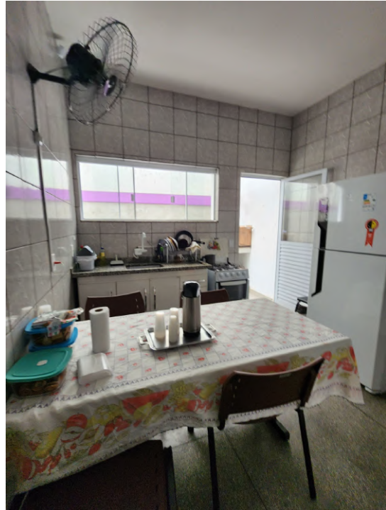
Figura 14 – Na cozinha será instalado novos pontos de elétrica de acordo com o projeto elétrico.
