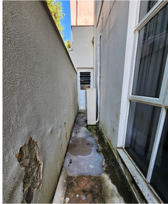
Figura 31 – Nos pisos externos laterais será assetado o porcelanato cerâmico, sendo realizado a limpeza e regularização do nível com massa antes da execução.
