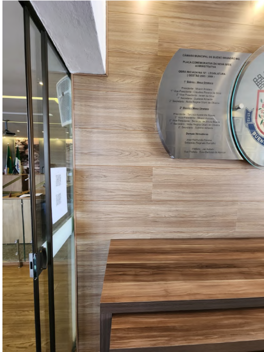
Figura 13 – Porta de acesso para o Plenário onde deverá ser realizada uma revisão, junto a todas as esquadrias do projeto serão revisadas e pintadas.
