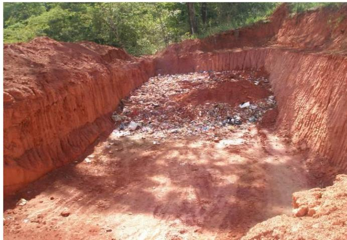
**Figura 35:** Vala de aterramento dos rejeitos.
