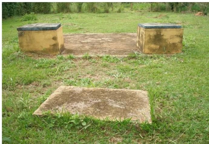
**Figura 36:** Sistema de efluentes do tipo fossa, filtro e sumidouro.
